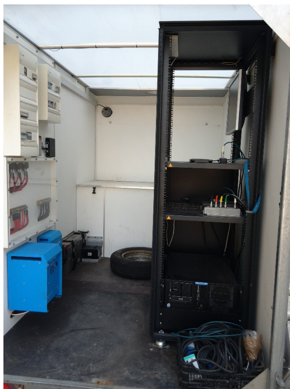
Obrázok 3 Interiér príviesného vozíka s rackom, záznamovým zariadením a elektroinštaláciou
